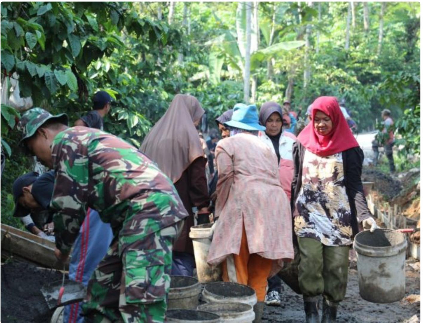
Ibu Ibu Bantu Percepat Pembangunan TMMD
