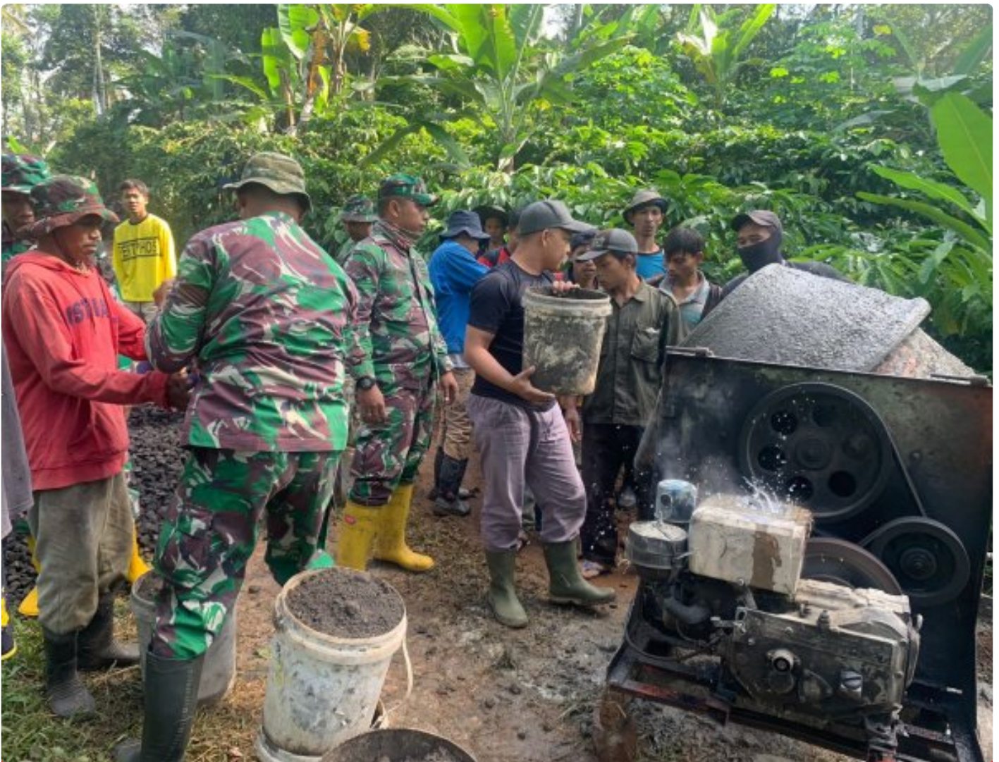
Campuran Cor harus Tepat Agar Betonisasi Kuat dan Tahan Lama
